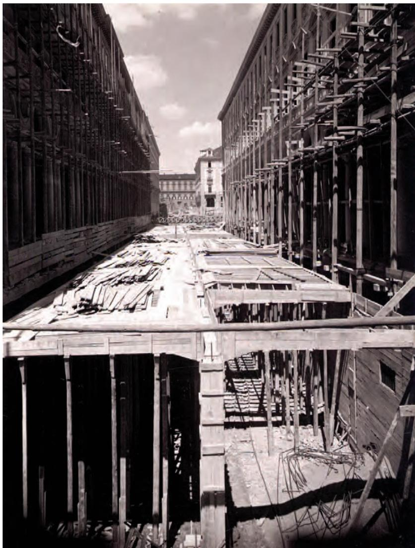
Fig. 3 - Via Roma. Vista da Sud del cantiere durante la formazione della soletta di copertura della Galleria sotterranea. (Gabinio 18E03\_56. Autore Gabinio M., 1933. Stampa alla gelatina bromuro d'argento, 112X85; Museo Gabinio). Su concessione della Fondazione Torino Musei. Divieto di riproduzione o duplicazione con qualsiasi mezzo.
